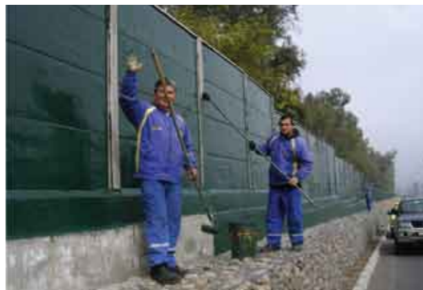
Aplicando Esmalte Sintético.
