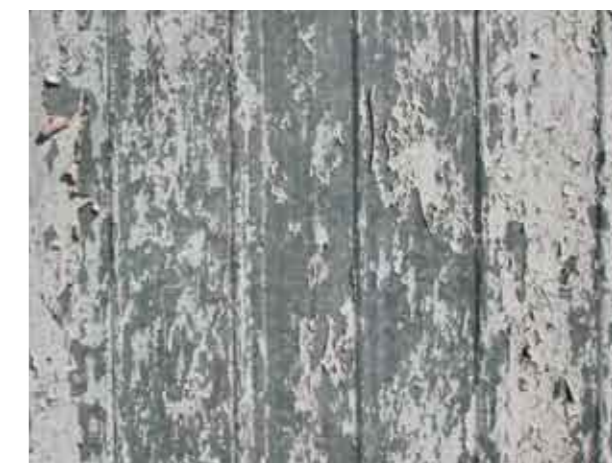
Detalle Óleo descascarado en madera
